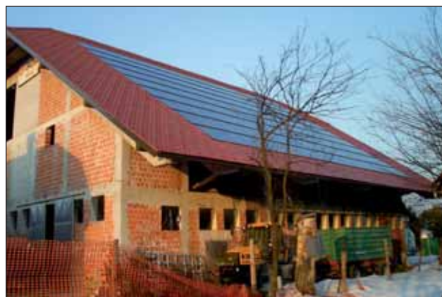
Fotonapetostni moduli nadomeščajo strešno kritino
